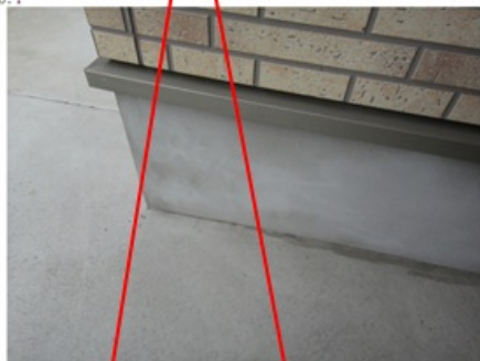
基礎 > 基礎表面 > モルタル仕上げ
